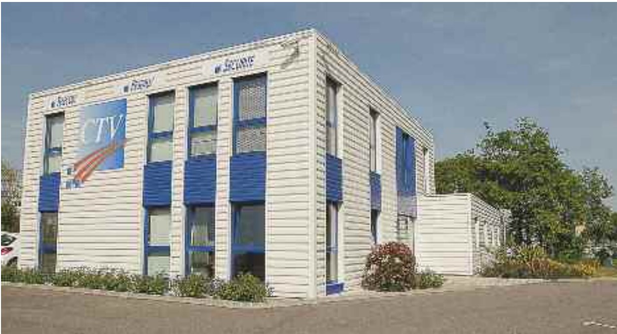
Bâtiment CTV à la Vertonne
